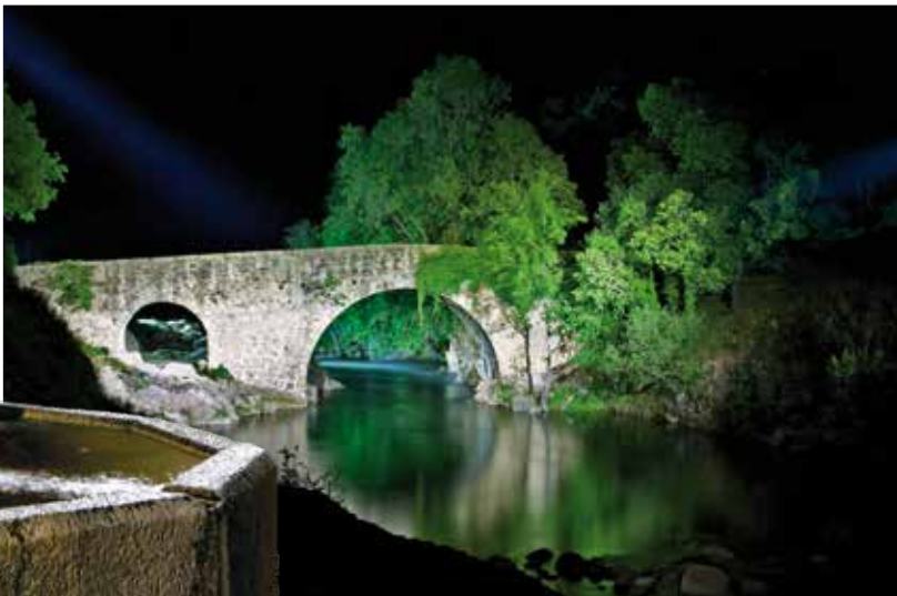
Puente de Cuartos (Cuartos Bridge) Angel María Romero
